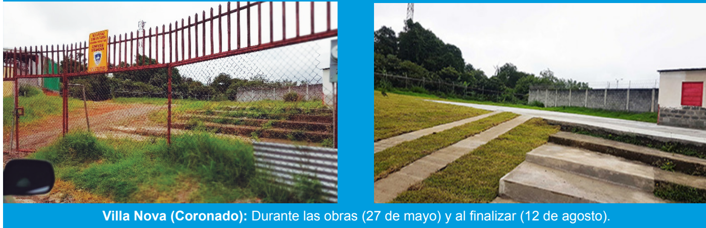
La Gacela (Tibás): Durante la construcción (13 de marzo) y al finalizar las obras (01 de agosto)
